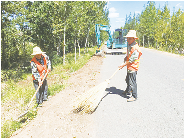
张家口市万全区地方道路管理站在“四好农村路”建设中,大力推进养护方式创新,采取人工加机械整理路肩的方法,节约了人力物力,提高了工作效率。图为养护工人正在县道整理路肩。于文龙 摄
