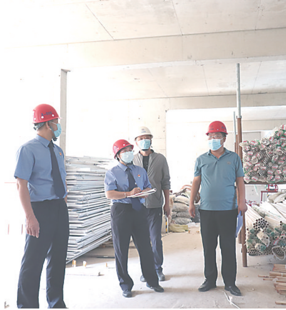
9月21日,霸州市人民检察院会同霸州市住房和城乡建设局深入辖区多个建筑工程施工现场开展安全生产专项监督活动。活动中,检察官等查看了建筑施工单位相关手续,重点针对施工工人安全防护措施等进行实地查看,提醒企业时刻绷紧安全生产这根弦,筑牢安全生产“防火墙”。图为专项监督活动现场。
