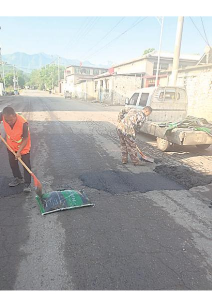
为进一步改善群众出行环境，消除农村公路路面病害，延长公路使用寿命，连日来，平山县地方道路管理站养护人员积极行动，组织人员、调配机械，开展农村公路路面坑槽小修挖补作业，对新井线、古栏线进行了沥青挖补作业。在作业中，养护人员选用性能优质的冷补料，严格施工工艺，恢复公路平整，有效改善了农村公路的通行条件，更好地服务沿线居民和过往车辆安全出行。图为古栏线挖补作业现场。 张锡霞 摄
