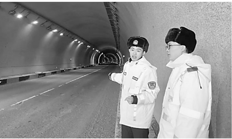
12月18日,高速交警围场大队联合路政部门开展隧道专项整治行动,排查隧道“黑白洞”安全隐患。他们通过实地驾车考察的方式,对隧道照明、道路状况等进行细致检查,特别针对长达5.6公里的大庙隧道存在的入口灯光较暗、内部有灯具损坏等问题,共同研究制定整改措施,确保及时整改到位,全力消除安全隐患。图为围场大队民警在隧道口排查安全隐患。 本报记者 王黎冬 摄
