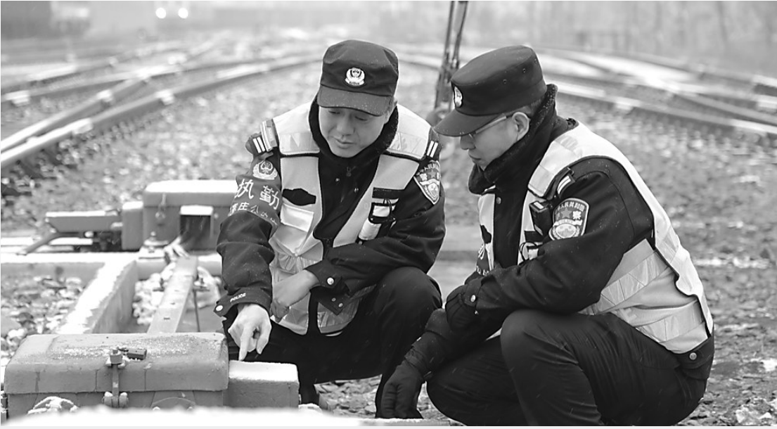
石家庄铁路公安处井陘站派出所持续做好排险除患工作,落实“全天候、全覆盖、全时段”巡查模式,强化日常监管与动态巡查,全力保障线路平安畅通。图为2月21日,井陘县普降小到中雪,民警雪后对线路铁路设备(转辙机)进行检查。
